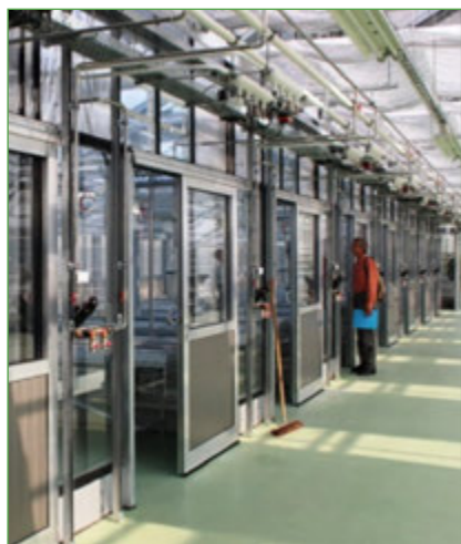
Begutachtung der neuen Gewächshauskabinen
