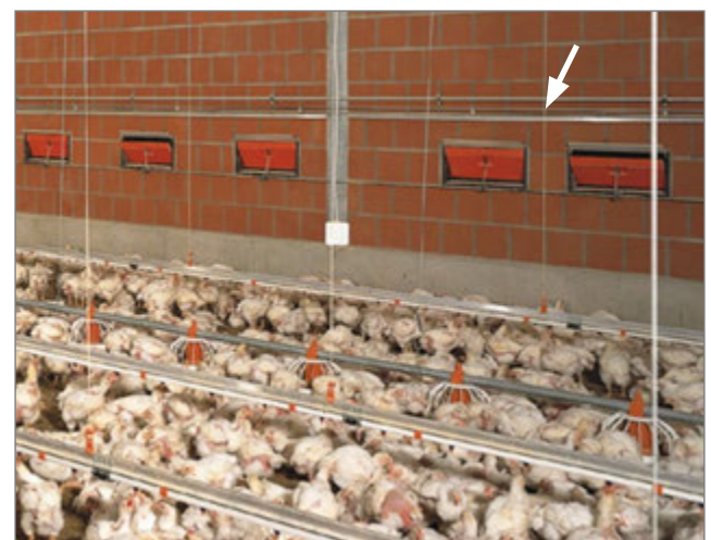
Zuluftkühlung über Vernebelungstechnik in einem Hähnchenmaststall
