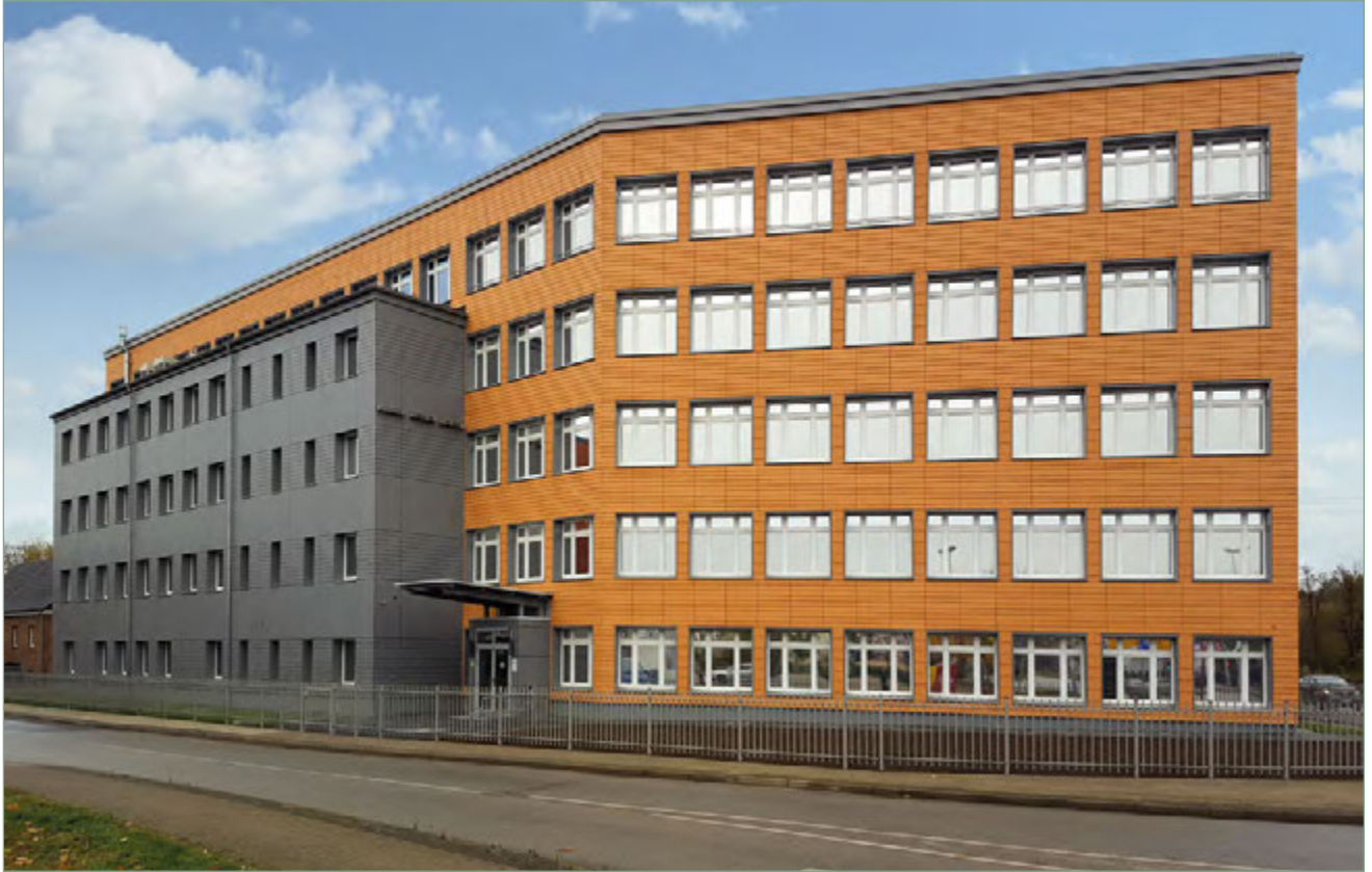
Sanierte Außenfassade des LALLF Neubrandenburg (Quelle: SBL 2019)
