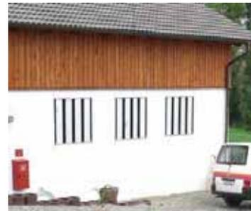
**Lüftungsöffnung,  $L_{WA}$ : 75-85 dB(A)
