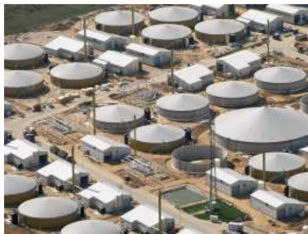
Abb. II-14: Im Bau befindlicher Bioenergiepark in Penkun - Bild: Fa. EnviTec
