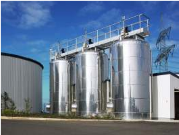
Abb. IV-4: Hygienisierungsanlage der Biogasanlage Malchin (mit freundlicher Genehmigung von Herrn Dr. Müller-Scheeßel, ReFood GmbH, NL Malchin)
