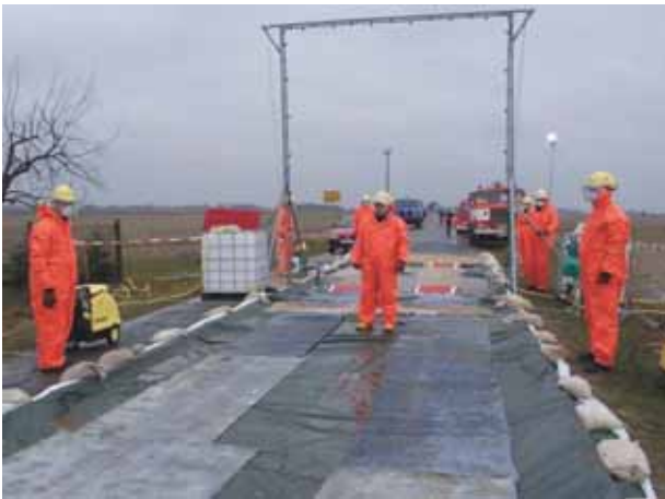
Tierseuchenübung: Aufbau einer Fahrzeug-Desinfektionsschleuse
